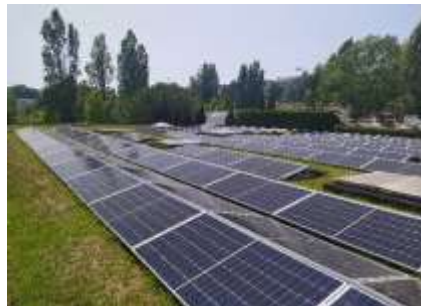
Instalação de Painéis Fotovoltaicos
