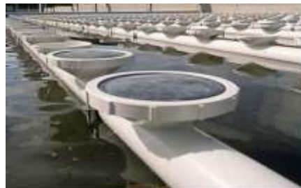
Substituição de Equipamentos por outros mais eficientes
